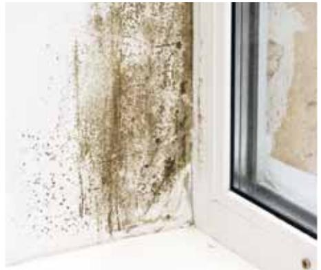
Wird die Zentralheizung in der kalten Jahreszeit z. B. tagsüber runter gedreht, reicht die zeitweise Beheizung am Abend nicht aus, um die ausgekühlten Wandflächen gleichermaßen mit der Raumluft zu erwärmen. Trifft die warme Raumluft auf die kalte Wand, besteht die Gefahr von Kondensatbildung auf der Oberfläche. Auch die Wahrnehmung der Behaglichkeit im Wohnraum wird durch das zeitweise Abschalten der Heizung beeinträchtigt. Die durch das Warm-Kalt-Gefälle zwischen Luft
